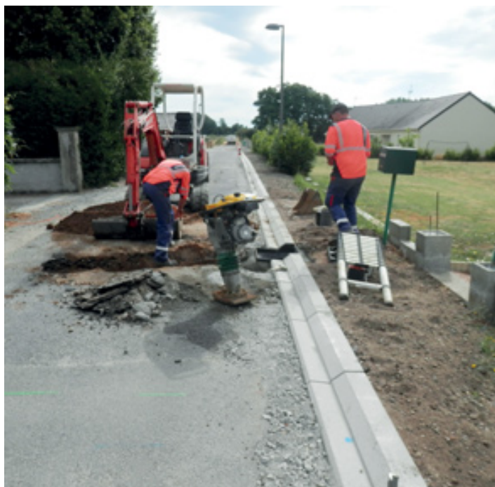
Travaux de voiries à « la petite Rigolée »
